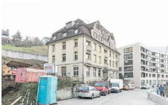
Anfang Februar startet der Abriss des «National»-Gebäudes.
